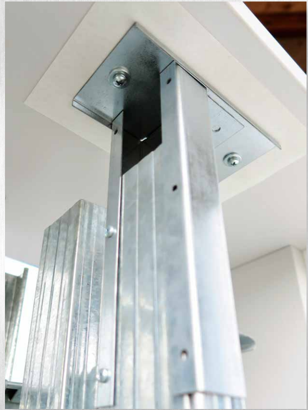
Höhenausgleich und Anschluss an Kellerdeckendämmung
